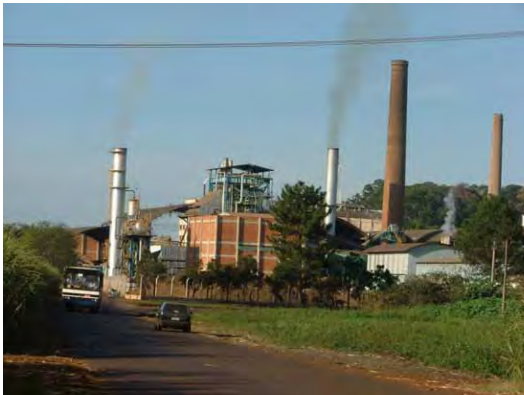
Foto 1.2 – Usina Santo Antônio, do Grupo Balbo
