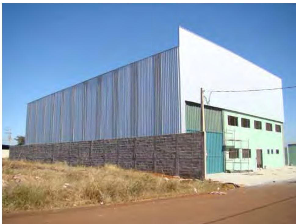
Foto 5.3 – Instalação industrial em fase final de construção.
