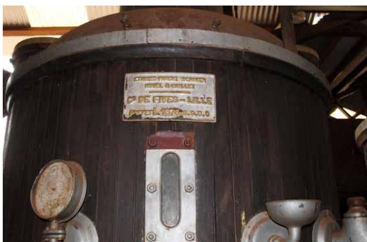
Um dos evaporadores do engenho
