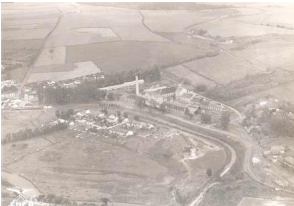
Figura 32– Aerofoto vista geral do Engenho Central Capivary/ Usina Raffard em vila em 1906. A fábrica posiciona-se no centro, na sua frente casa para funcionários graduados e diretores. Fonte: CAMPAGNOL, 2008, p.227.
