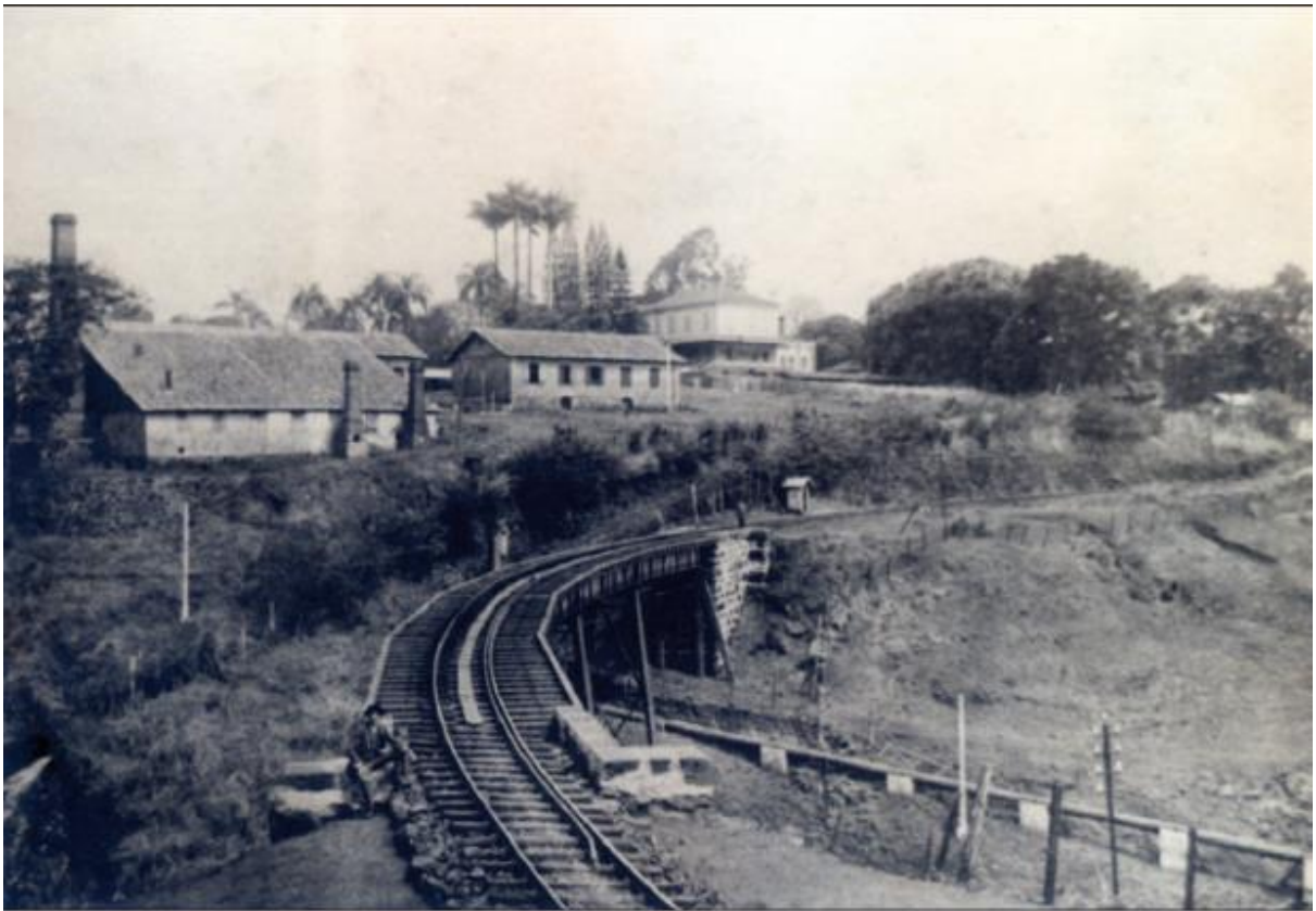
Figura 4- Fazenda Buenópolis. Estrada de Ferro Mogiana passando perto da casa-grande e do Conjunto de Beneficiamento de Café. Fonte: Foto antiga, s.p apud FREITAS, 2015, p. 151.
