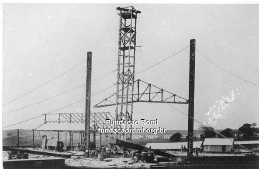
Figura 75- Construção da Usina Santa Barbara no início do século XX.
