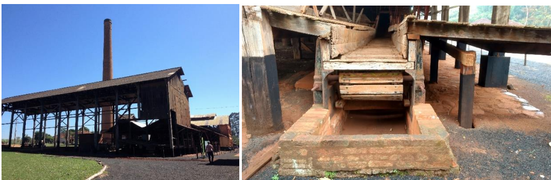
Figura 92 e 93- Barracão de recepção da cana-de-açúcar e esteira transportadora Engenho Central Schmidt. Fonte: Camila Paulucci, 2017.
