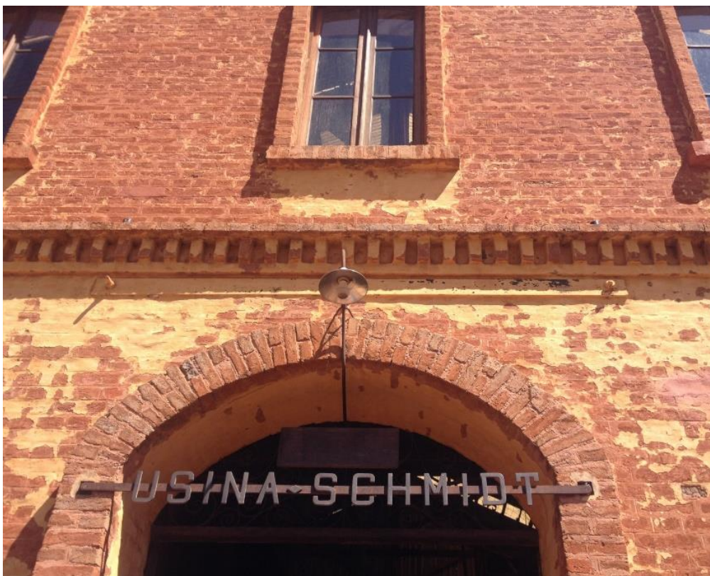
Figura 43– Detalhes fachada Usina Schmidt. Foto: Camila Paulucci, 2017.
