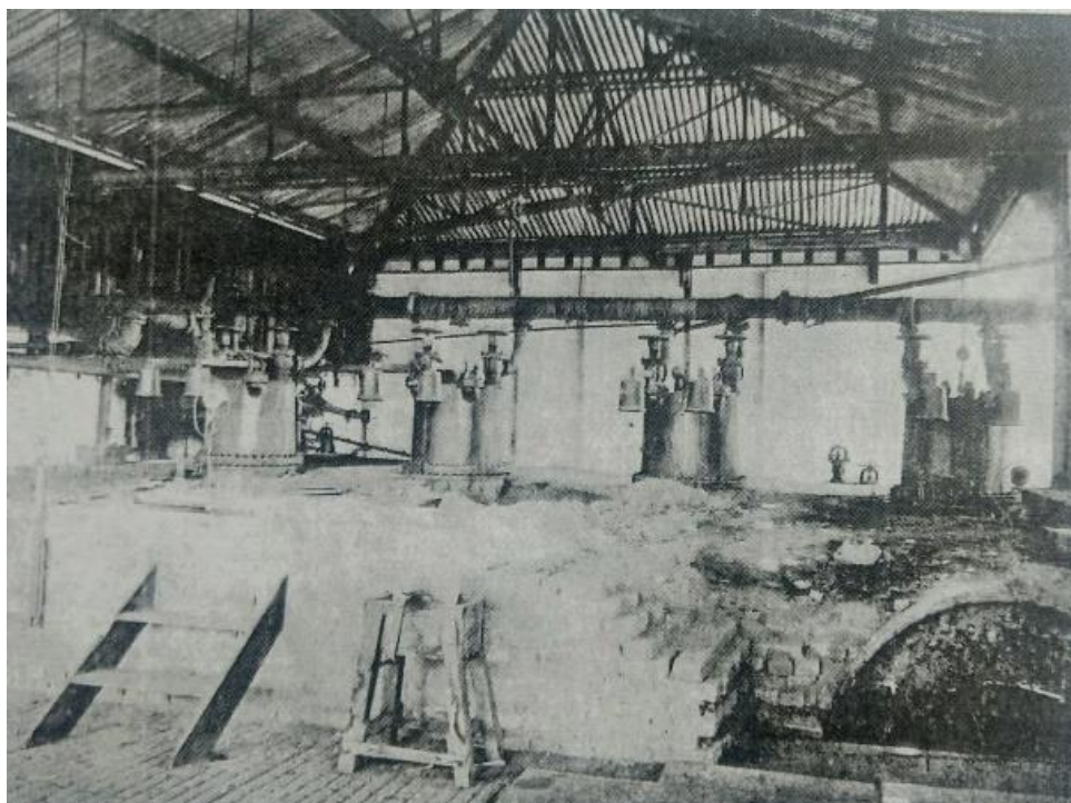
Figura 26- Caldeiras do Engenho Central de Porto Feliz em 1912 Fonte: SOBRINHO, 1912, p.70
