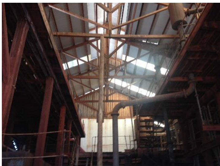
Figura 44 – Interior da usina, tesouras de madeira e mezanino de aço Foto: Camila Paulucci, 2017.
