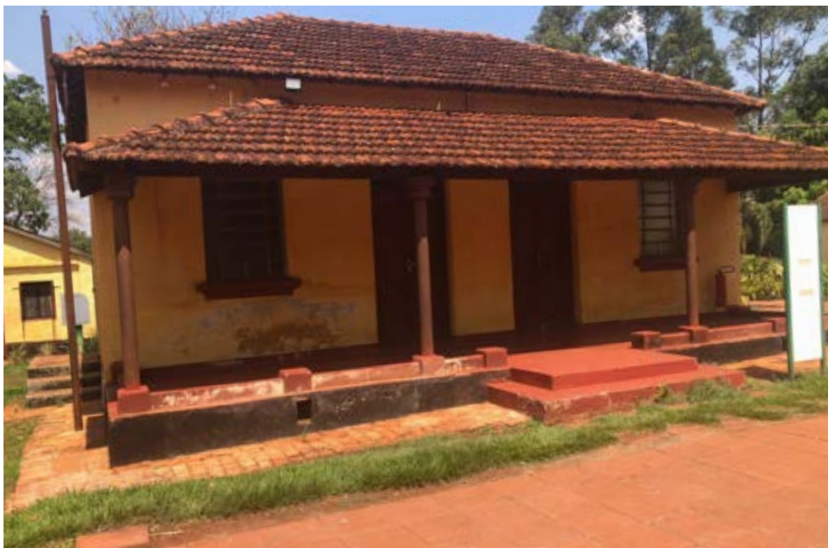
Uma das edificações de apoio. Foto 2023, arquivo do museu da Cana.
