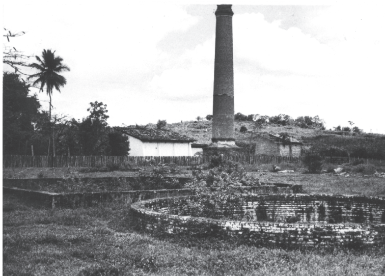
Engenho central da Pojuca, 1983 Tanque (circular), local das máquinas (retangular) e chaminé
