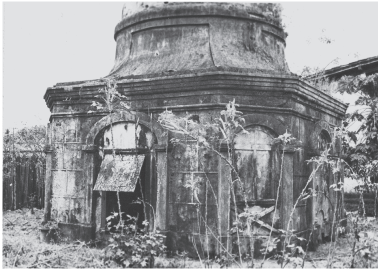
Engenho central da Pojuca, 1983 Detalhe da base da chaminé
