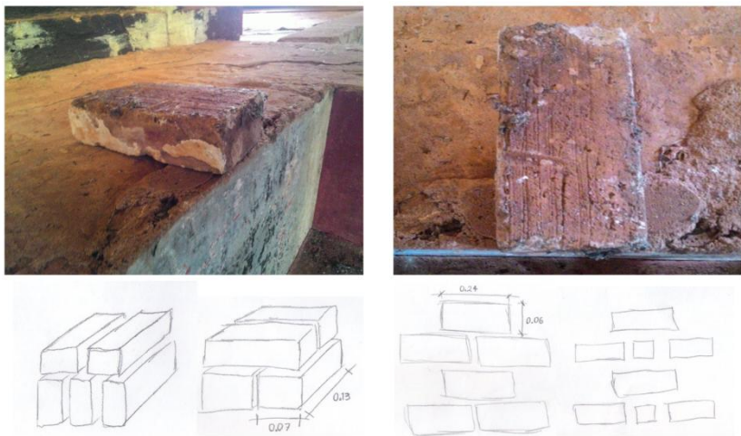
Img-39- tipologia de tijolos e e amarrações encontradas.
