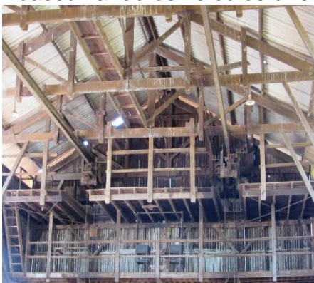
Img.-04-zona de descarregamento.
