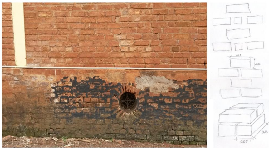
Img-38- tipologia de amarração encontrada na lateral da destilaria.
