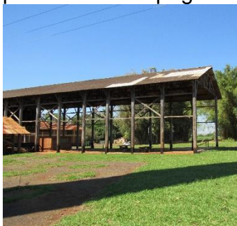
Img.-02- galpão da balança.
